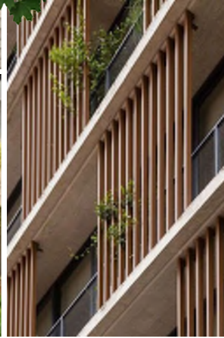
Houten latten als privacyschermen en bij galerijen
